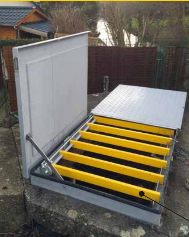
Trappe d'accès avec barres anti-chute
